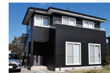
色:チョコレート 施工時期:2022年4月
