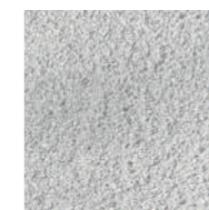
施工直後のUP
