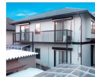
施工から5年経過後の様子
