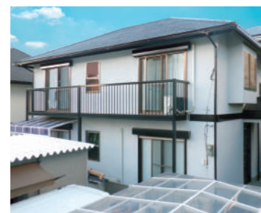
施工直後の様子
