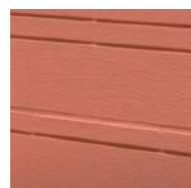
施工直後のUP
